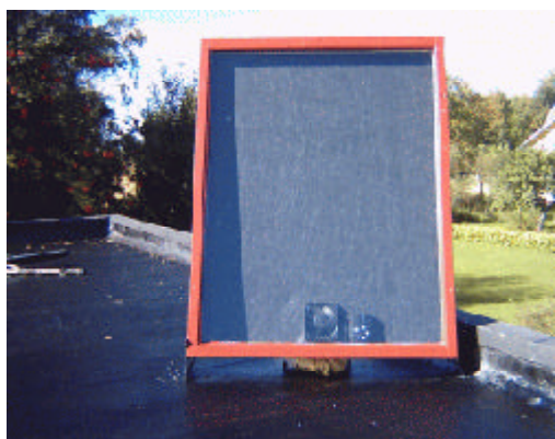
SOLTAN på garagetak. Varm, torr uteluft blåser in i garaget och värmer och torkar garage och bil
