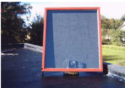
SOLTAN på garagetak. Varm, torr uteluft blåser in i garaget och värmer och torkar garage och bil
